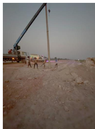
Til venstre; Opfyldning af jord til midlertidig bro, så det bliver muligt at køre i bil til det kommende center. Til højre; Installering af elmaster.
